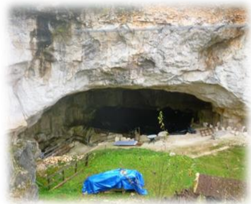
Entrée des carrières souterraines
